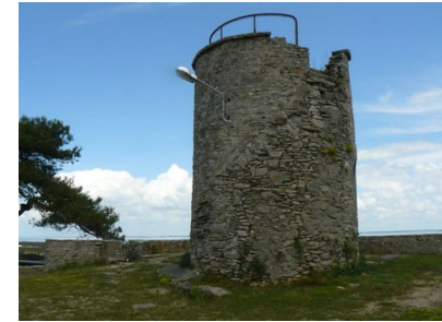
La tour (réserve de matériel de plein air)
